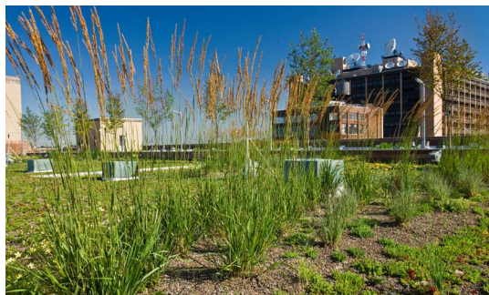
USPS a aménagé un toit vert à New York. (Photo: USPS)
