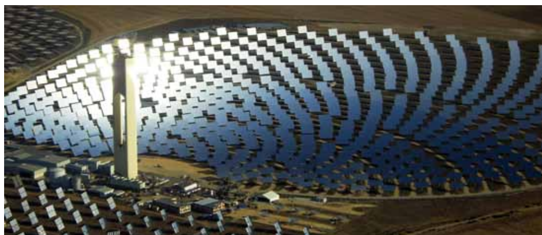
Nueva planta de paneles solares PS20 en construcción en España, próxima a la planta PS10. A una altura de 115 metros, la planta PS10 se alimenta de 624 helióstatos espejados. A 165 metros, la planta PS20 funciona con 1 255 helióstatos. La planta PS20 ha sido diseñada para producir el doble de energía que su vecina más pequeña de 11 MW. Aunque no son las primeras "torres de energía" del mundo, son las primeras concebidas a semejante escala. Crédito: Abengoa Solar
