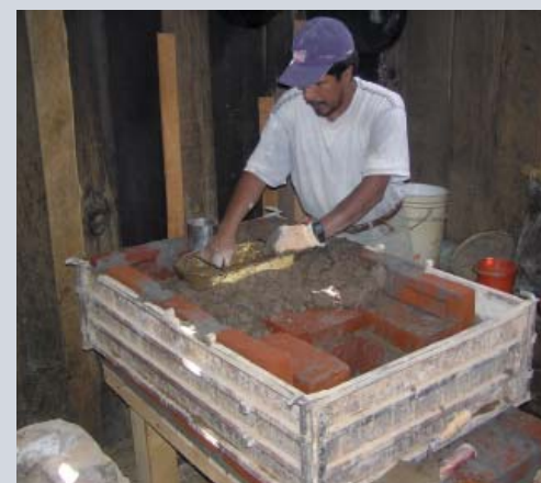
Опытный мастер может сделать плиту Patsari за 40 минут. С появлением этих плит здоровье использующих их для приготовления пищи женщин существенно улучшилось. Использование таких плит также позволяет уменьшить уровень загрязнения воздуха и потребление дров.
