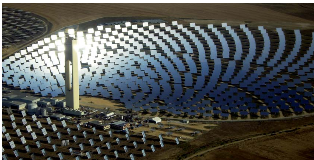
En Espagne, une nouvelle centrale solaire baptisée PS20 est en cours de construction près de la centrale PS10. Du haut de ses 115 mètres, la centrale PS10 est alimentée par 624 héliostats. La tour de la centrale PS20 s'élève à 165 mètres et est alimentée par 1 255 héliostats. La centrale PS20 a été conçue pour produire deux fois plus d'énergie que sa voisine de 11 MW. Bien qu'il ne s'agisse pas des premières centrales à tour, ce sont les premières d'une telle envergure. Photo : Abengoa Solar
