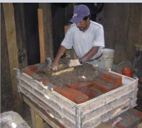
يستطيع أي حرفي ماهر تجميع موقد Patsari في ٤٠ دقيقة. ومنذ استخدام هذه الموائد، ظهر تحسن ملحوظ في صحة النساء اللاتي يستخدمنها في الطهي المنزلي. وأدى استخدام هذه الموائد إلى انخفاض تلوث الهواء واستهلاك الحطب.
