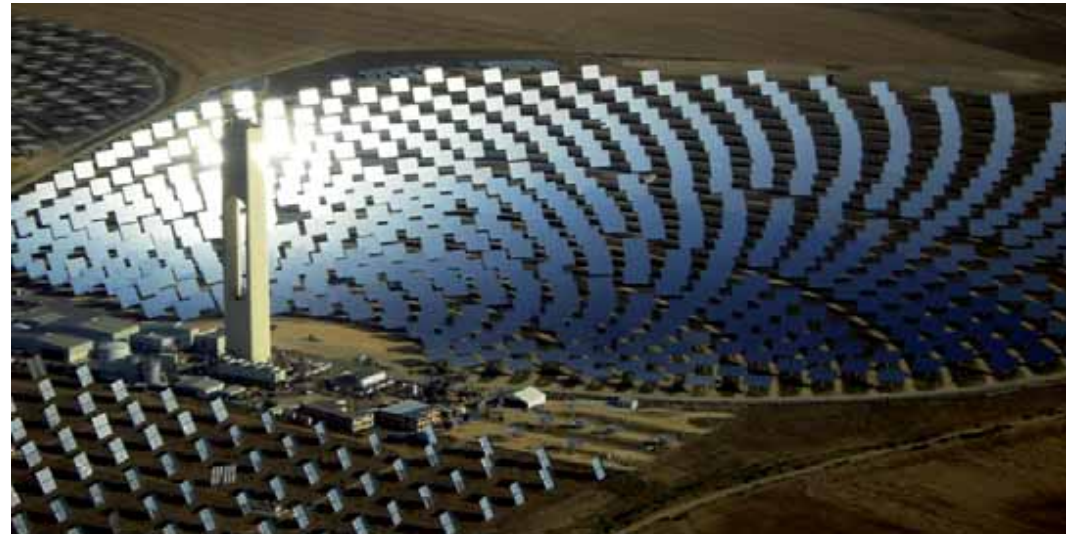
في أسبانيا، يجري حالياً إنشاء مصنع PS20 الجديد للوحات الشمسية إلى جانب مصنع PS10. وزُود PS10 بعدد ٦٢٤ هليوستات عاكساً على ارتفاع ١١٥ متراً، فيما زُود PS20 بعدد ١٢٥٥ هليوستات على ارتفاع ١٦٥ متراً. وقد صُمم PS20 لإنتاج ضعف الطاقة التي ينتجها جاره الأصغر الذي ينتج ١١ ميجاوات. ورغم أنها ليست "أبراج الطاقة" الأولى في العالم، إلا أنها المصانع الأولى التي يُنظر إليها على هذا النحو.
