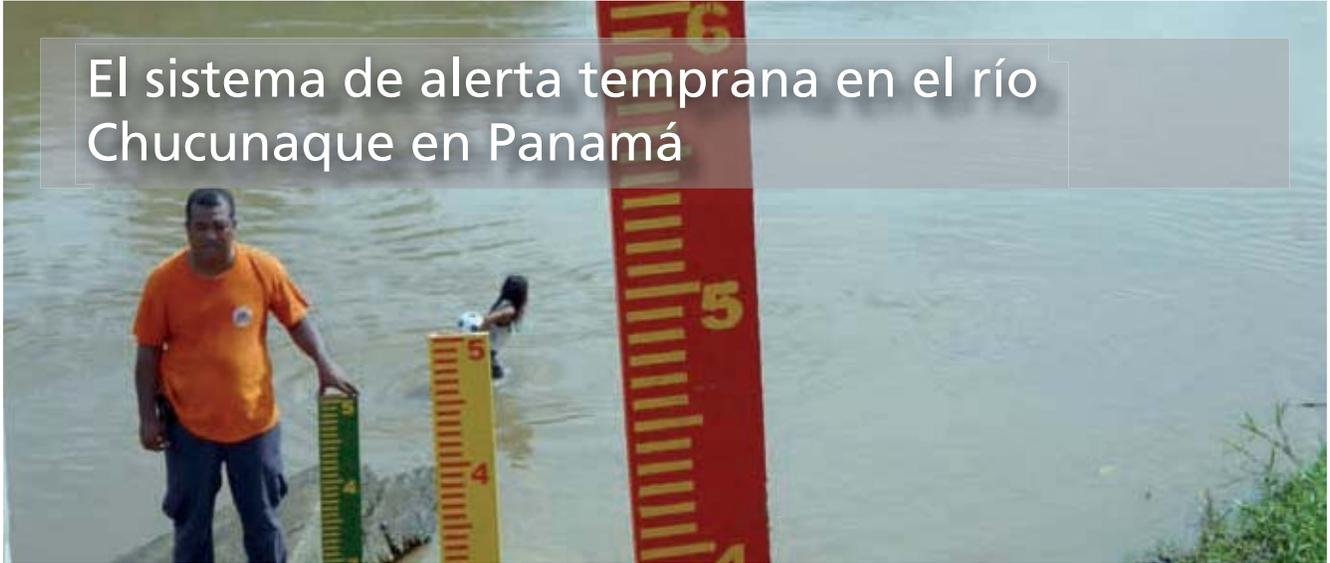
Instalación de una escala limnimétrica en el río Chucunaque junto a la comunidad de El Salto, Panamá
