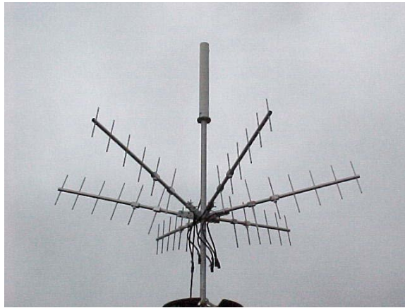
FIGURA 3-6 Sistemas de antenas omnidireccionales y directivas (401-406 MHz)
