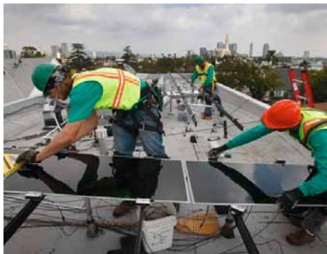
Instalación de paneles solares
