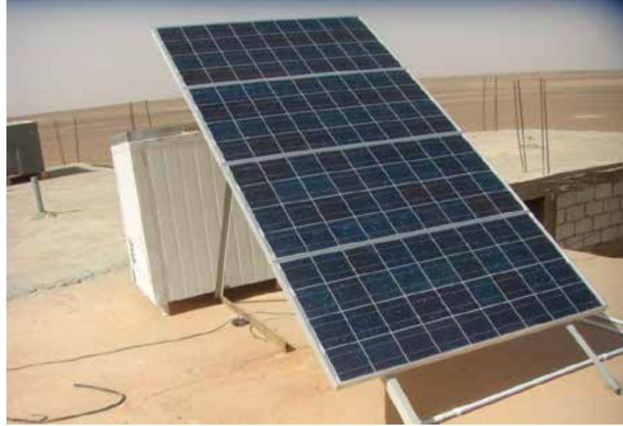
الشكل 2- نظام الطاقة الشمسية المنزلي 400 واط. ذروة
