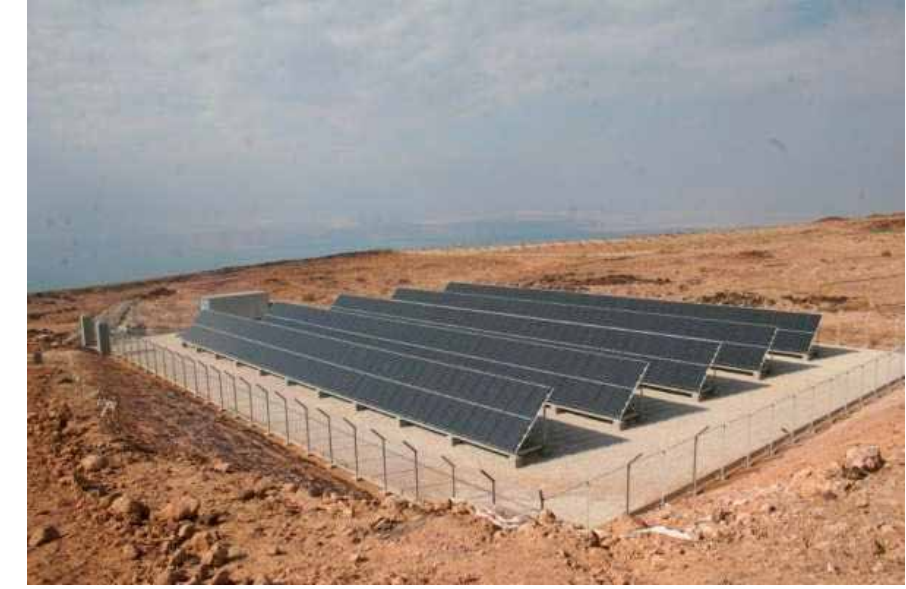
الشكل 9- نظام خلايا شمسية مربوط مع الشبكة بقدرة 100 كيلو واط.ذروة في مجمع بانوراما - البحر الميت
