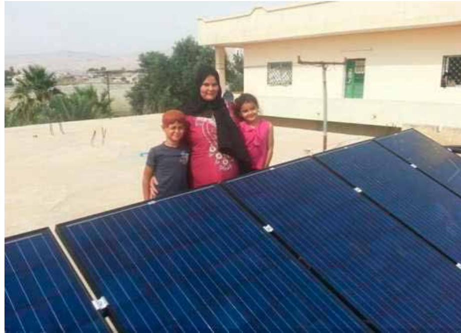
الشكل 13- مثال على نظام خلايا شمسية تم تركيبه ضمن المشروع
