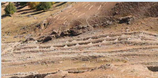
Dighe di contenimento, argini e piantagioni di alberi per stabilizzare i pendii
