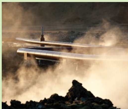
Рис. 3.1.12. Трубопровод геотермальной электростанции.
