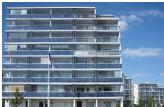
Рис. 3.2.12. Виики – квартал зданий с низкими энергозатратами в Хельсинки (Финляндия). В фасад здания встроены панели, аккумулирующие солнечную энергию.
