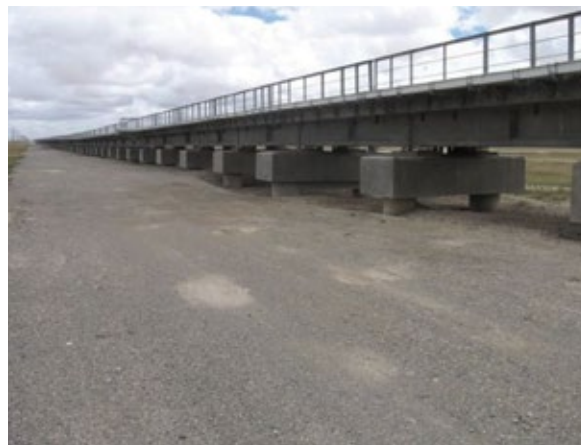
Рис. 2.8.14. Дорога на специальных заглублённых в землю опорах.
