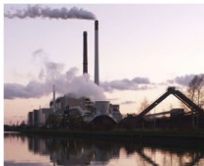
ТЭС, работающая на каменном угле.
